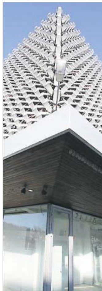
Ist die markante Fassade bald schrottreif?
