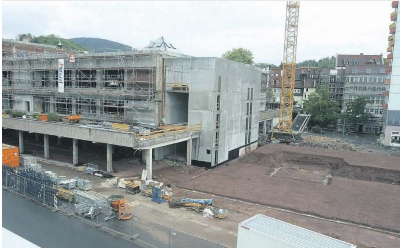
Seit nunmehr fünf Wochen tut sich nichts mehr am entkernten Kaufhof und dem begonnenen Parkhaus. Subunternehmen haben bereits ihre Ausrüstung abgeholt. Wie und wann es weitergeht, ist bis dato ungewiss. FOTO: frankphoto.de
