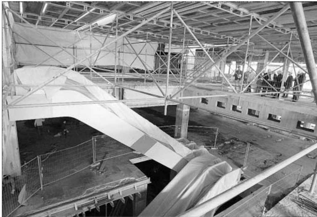
Die Rolltreppen sind im neuen Shopping-Centrum mittig im großzügigen Lichtschacht unter der Glaspyramide eingebaut. Hier soll auch ein Café Platz finden. FOTOS (6): frankphoto.de
