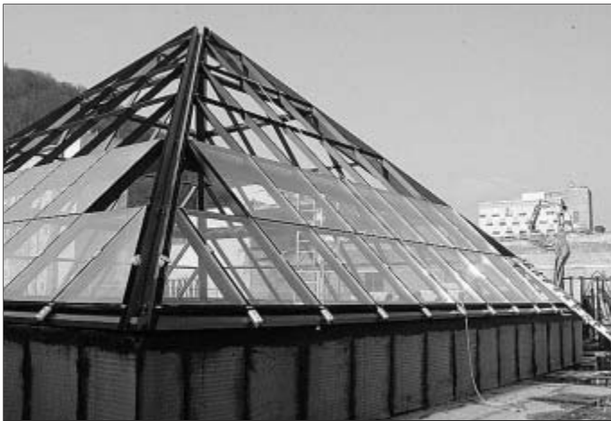
Stück für Stück wird das Haus von oben her dicht gemacht. Auch die markante Pyramide auf dem Dach bekommt ihre Glasscheiben.
