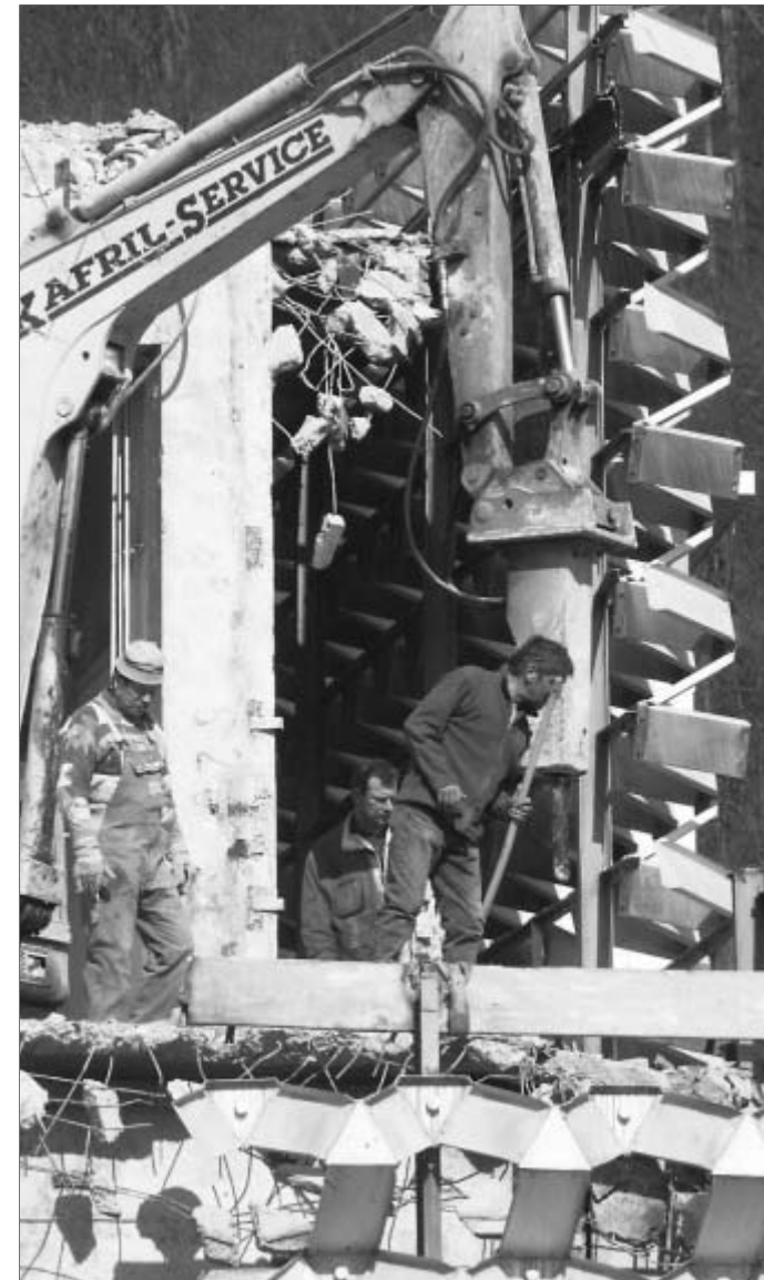
Die letzten Reste der markanten Alu-Waben fallen. Mit dem Verlust seiner Fassade hört das alte Centrum-Warenhaus für viele Suhler nun endgültig auf zu existieren.
