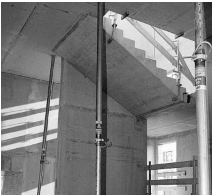
Während am alten Kaufhof noch rückgebaut wird, wächst bereits der aus Betonelementen gefertigte Verbinder zum Parkhaus.
