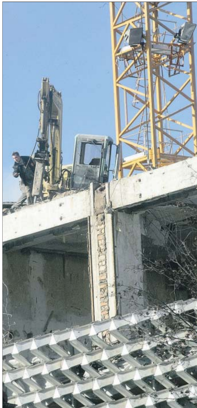
Der Rückbau der vierten und fünften Ebene des einstigen Kaufhofs ist abgeschlossen, so dass im Innern nun Gründung- und Abfangarbeiten auf der Tagesordnung stehen.
