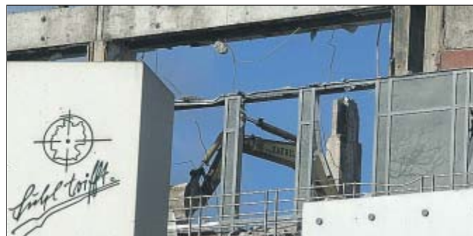
Auf der Baustelle sind täglich an die 50, 60 Bauleute anzutreffen.
