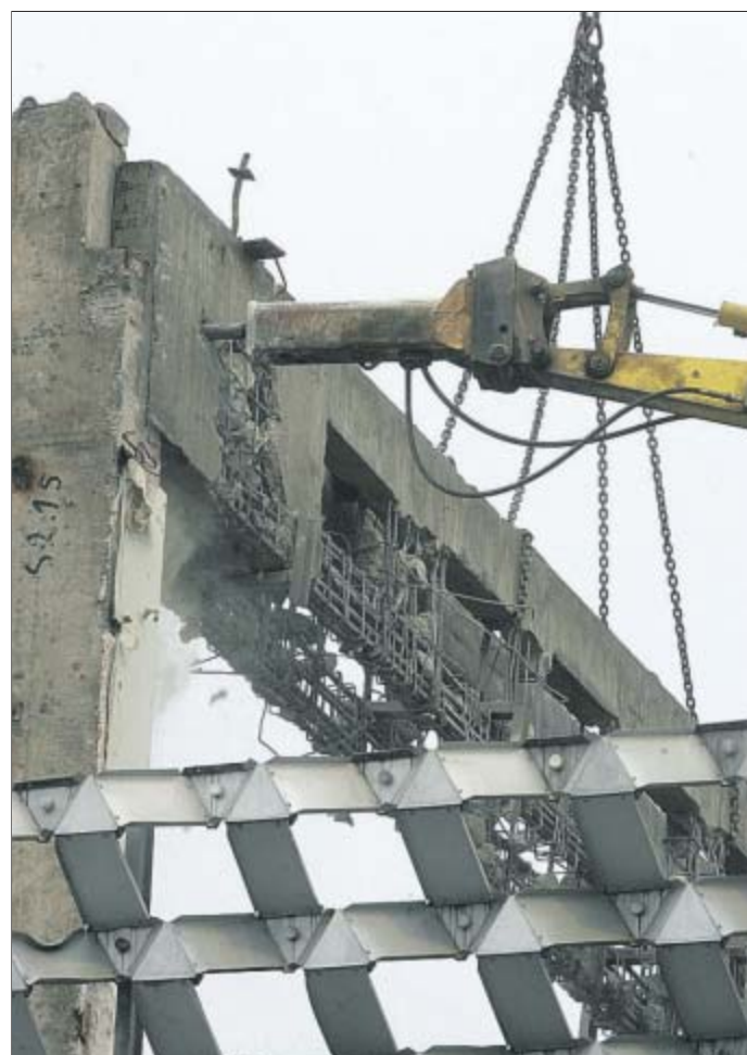
Meter um Meter stemmt der Bagger mit seinem hydraulischem Aufbruchhammer die Betonwände auf.
