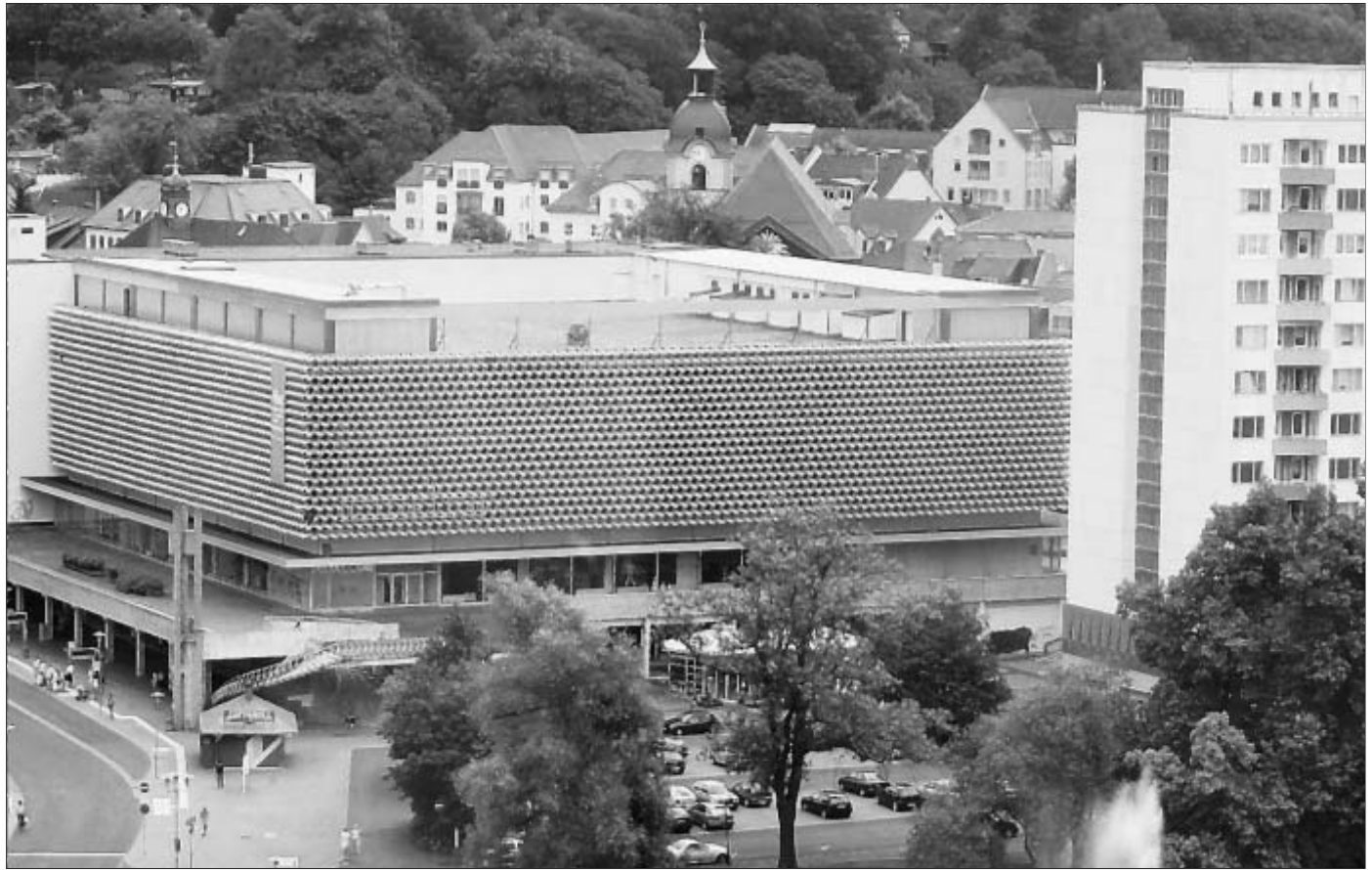
Noch ein vertrauter Anblick, doch bald unwiderruflich Vergangenheit: Suhls ehemaliges Centrum. FOTOS: frankphoto.de
