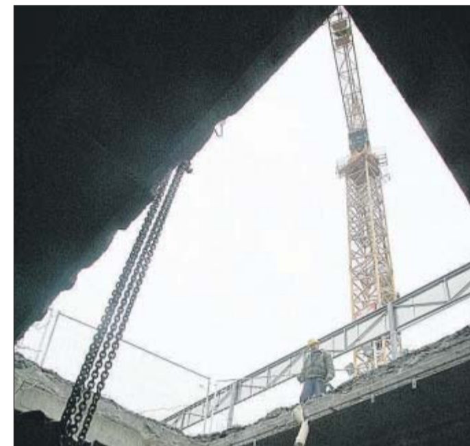
Kranzugang über ein Loch im Dach. FOTOS (4): frankphoto.de
