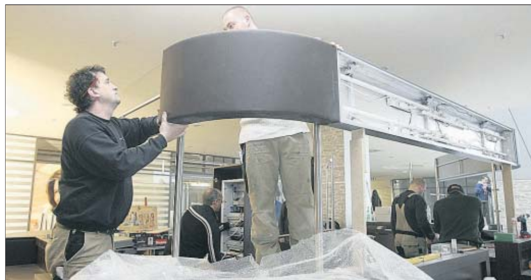
Mitarbeiter einer Firma aus Dermbach in der Rhön bauen die Cafëbar im Zentrum des Hauses ein.
