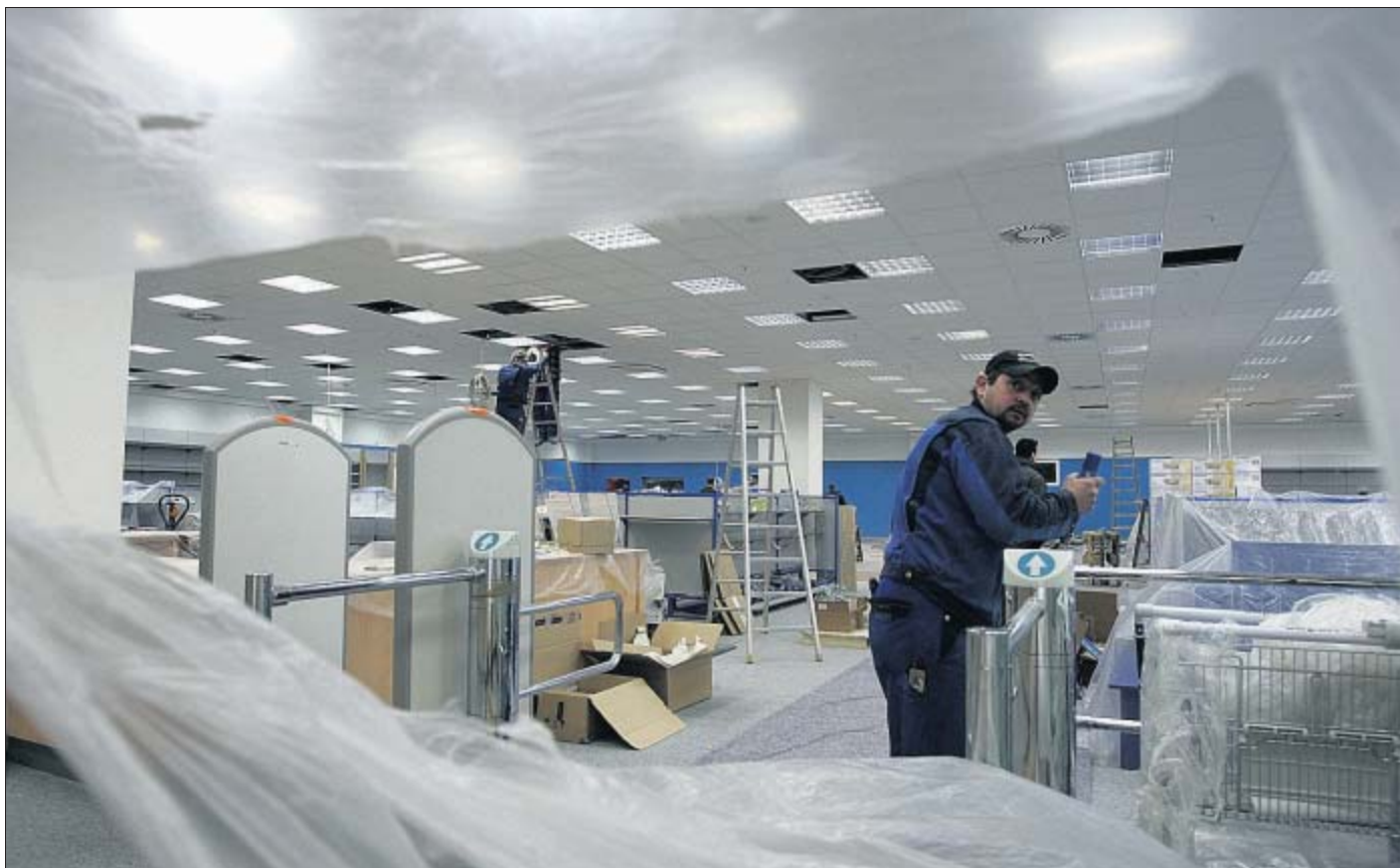
...während bei Heinze & Bolek eine Etage darüber die Elektriker Strippen ziehen und erste Ware eingeräumt wird. Fotos (4): frankphoto.de
