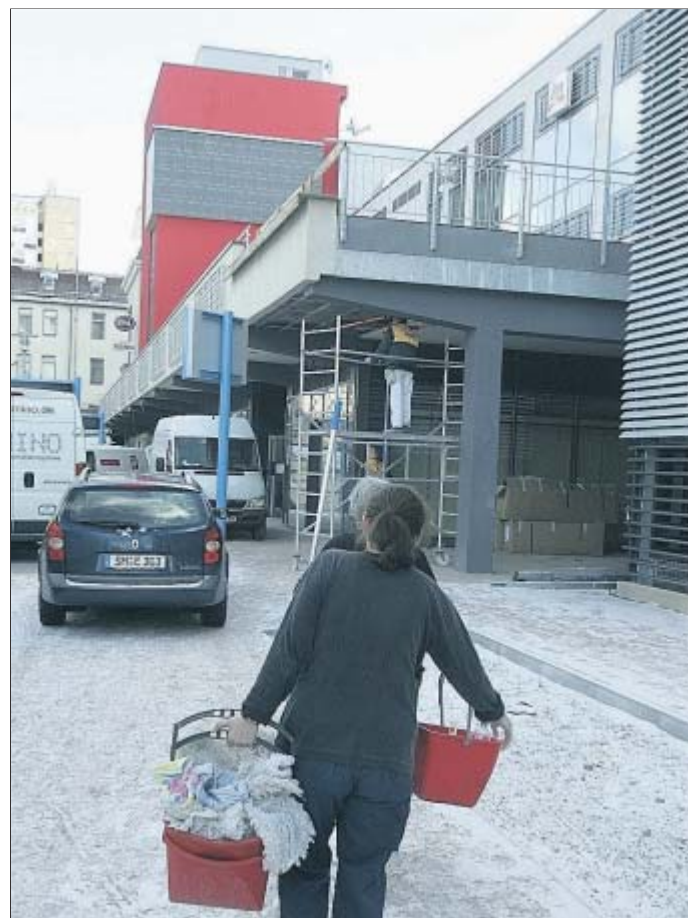
Der Baudreck muss weg: Wo die Handwerker fertig sind, rücken die Putzfrauen an. Sie haben reichlich zu tun.
