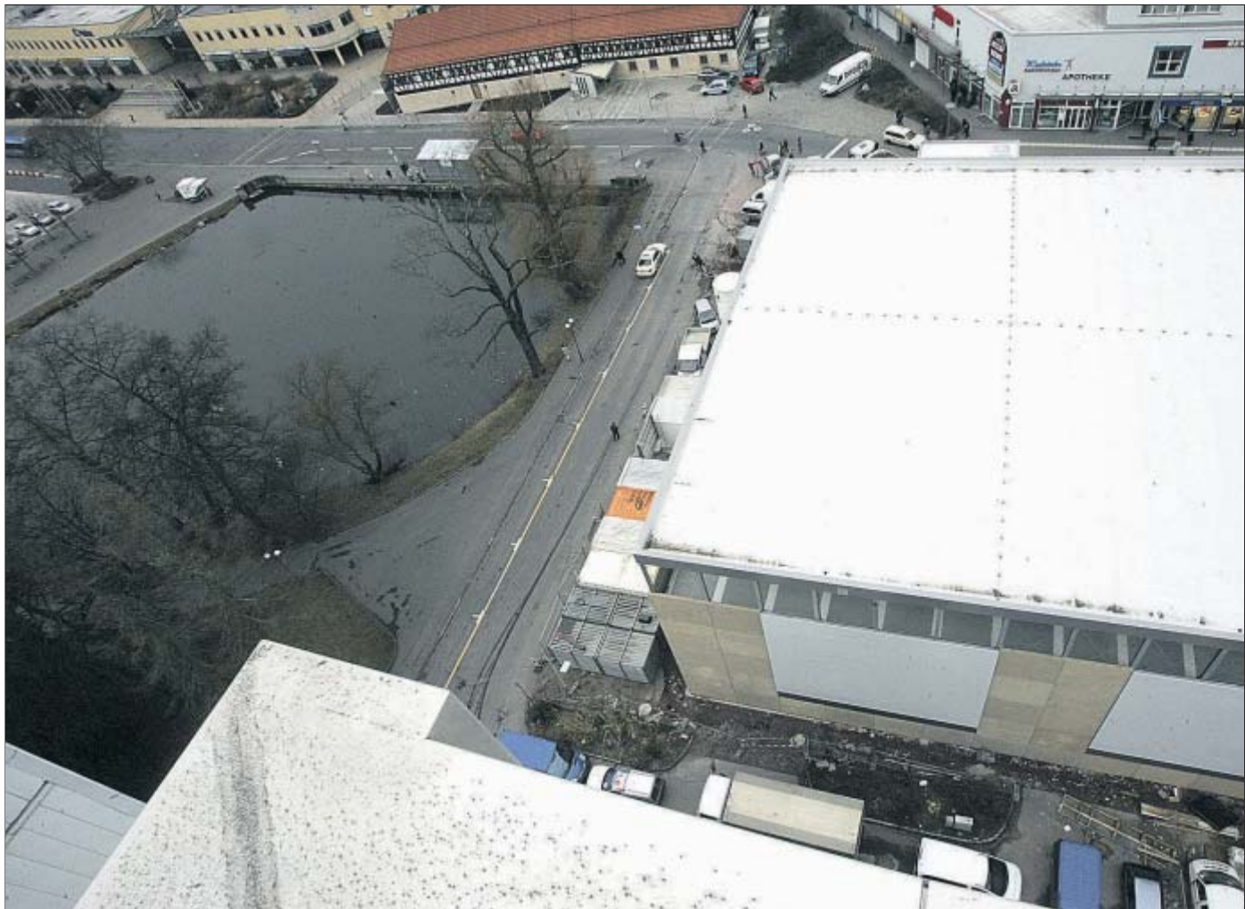
Noch ist das Areal zwischen Herrenteich und Parkhaus Baustelle, doch bald wird sich hier Einiges positiv verändern.
