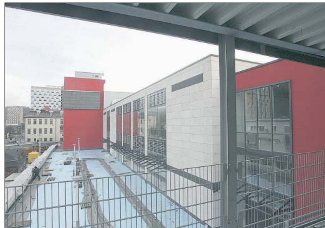
Die Center-Terrasse ist für den Brückenschlag zum Lauterbogen-Center vorbereitet. Fotos: frankphoto.de
