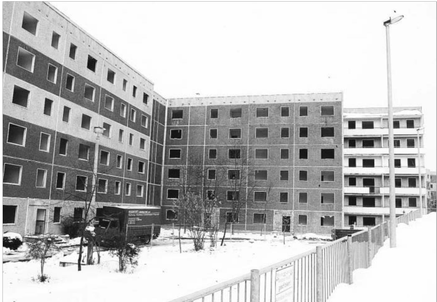
Der Plattenbau in der Kornbergstraße wird derzeit noch entkernt. Mitte Januar ist der Abriss geplant.
