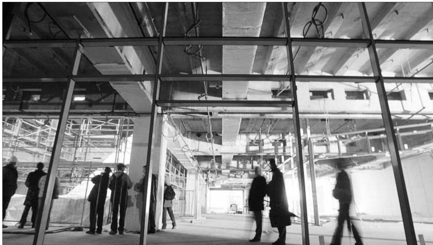
Die einzelnen Geschäfte des Einkaufszentrums sind bereits mit Glasfronten abgetrennt. Auch die Lüftungsanlage ist eingebaut. Bei einer Führung gab gestern die Bauwi als Generalauftragnehmer Einblicke in den Stand des Umbaus.
