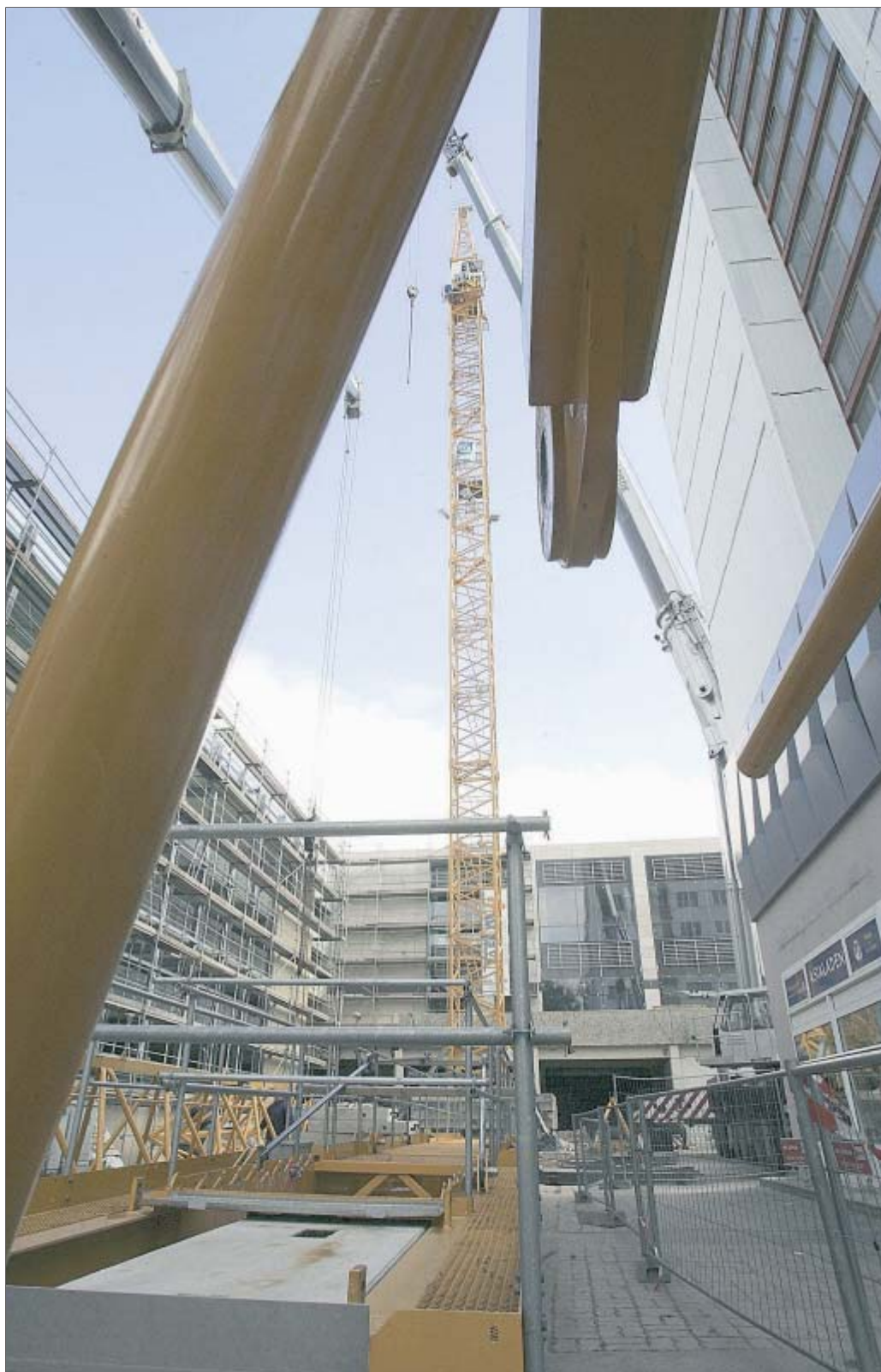
Zusammenbau des Krans. Damit sind große Arbeiten im Außenbereich Geschichte.
