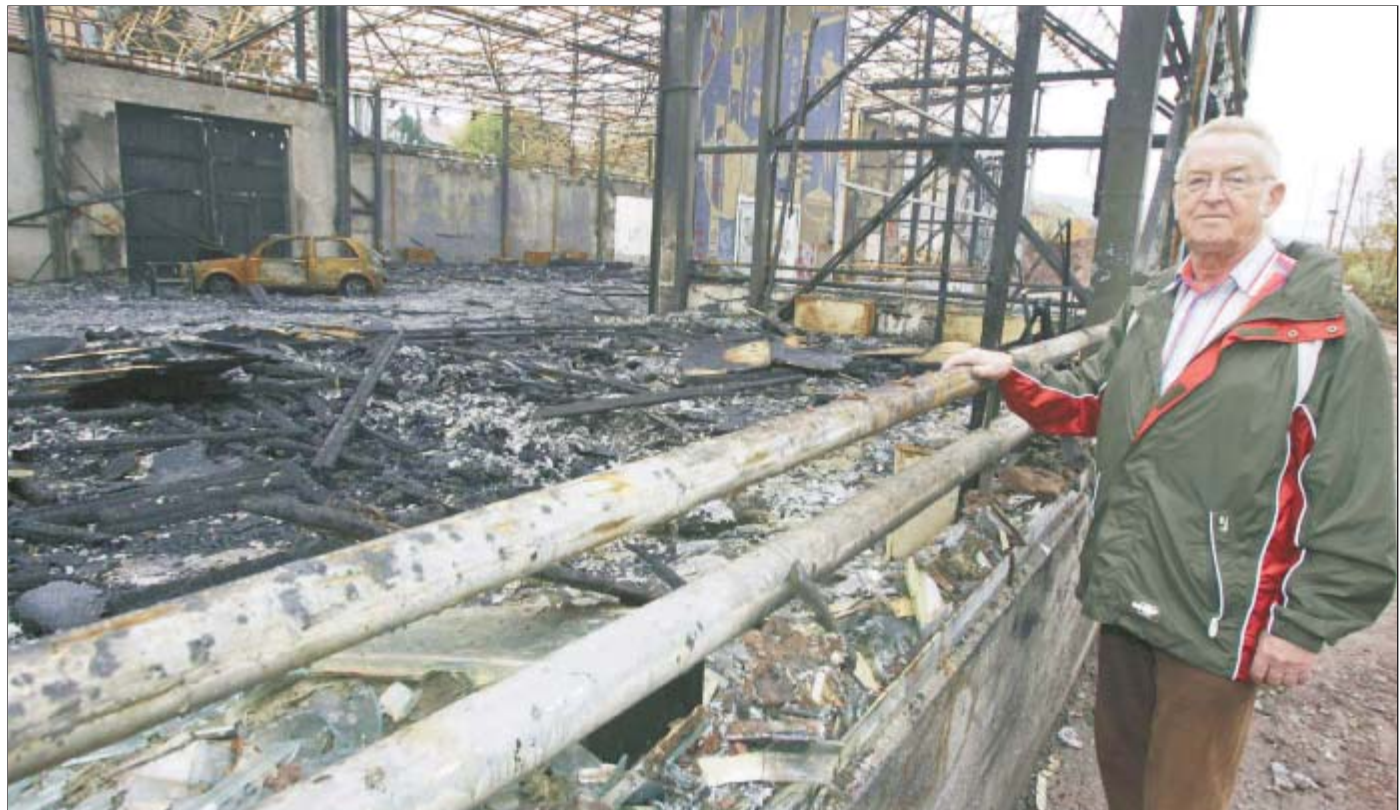
Peter Kuhn vor der Brandruine der Ausstellungshallen, die er vor 38 Jahren als Bauleiter hochgezogen hat. Sein Schwager, Prof. Oskar Büttner, entwickelte die einmalige Dachkonstruktion, ein sogenanntes Raumstabwerk. Foto: frankphoto.de
